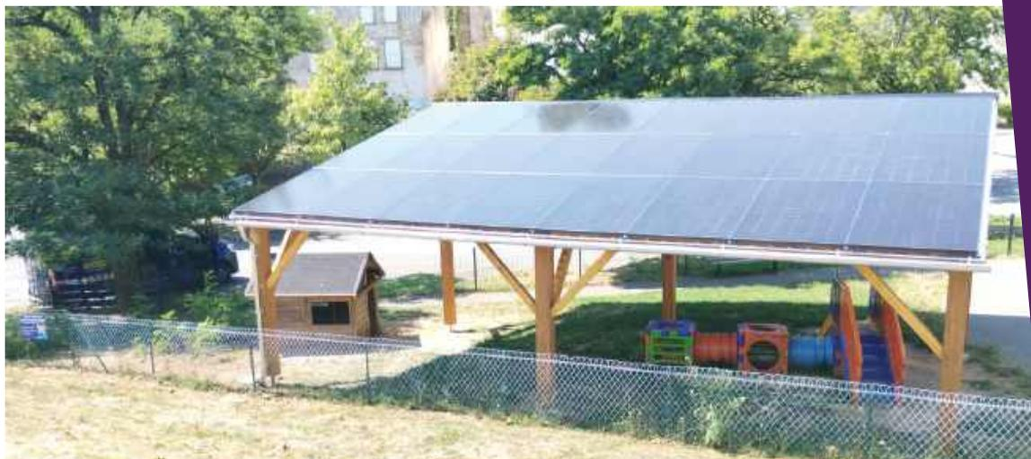
Création d'un car port de 50 m<sup>2</sup>, un car port bois permettant l'installation de 24 panneaux photovoltaïques.
